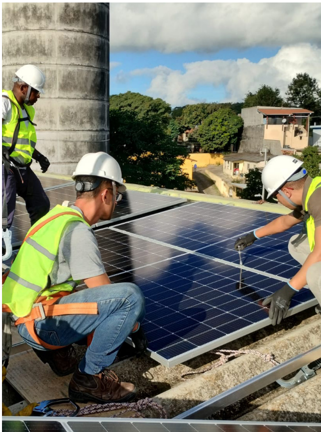
Instalação de placas solares no conjunto habitacional Paulo Freire, 2024. Cidade Tiradentes, São Paulo/SP
