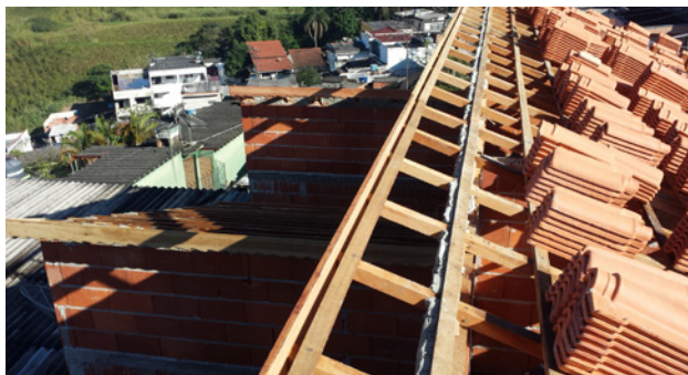
← Imagem: Telhado cerâmico com estrutura de madeira.
