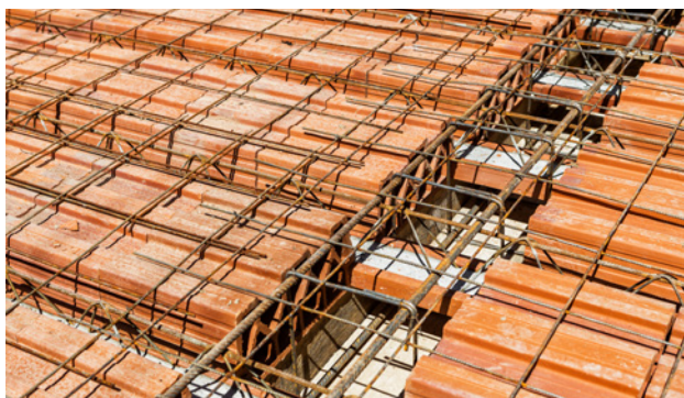
← Imagem: Laje treliçada com blocos cerâmicos.
