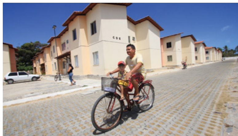
Residencial Aquiraz - CE
